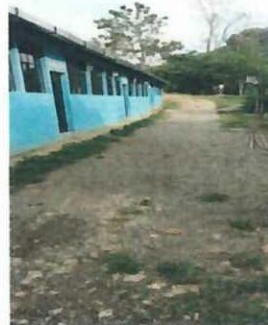
Foto 2: Se hará la fundición de 152 m2 losa de piso y cambio de canales metálicos.
